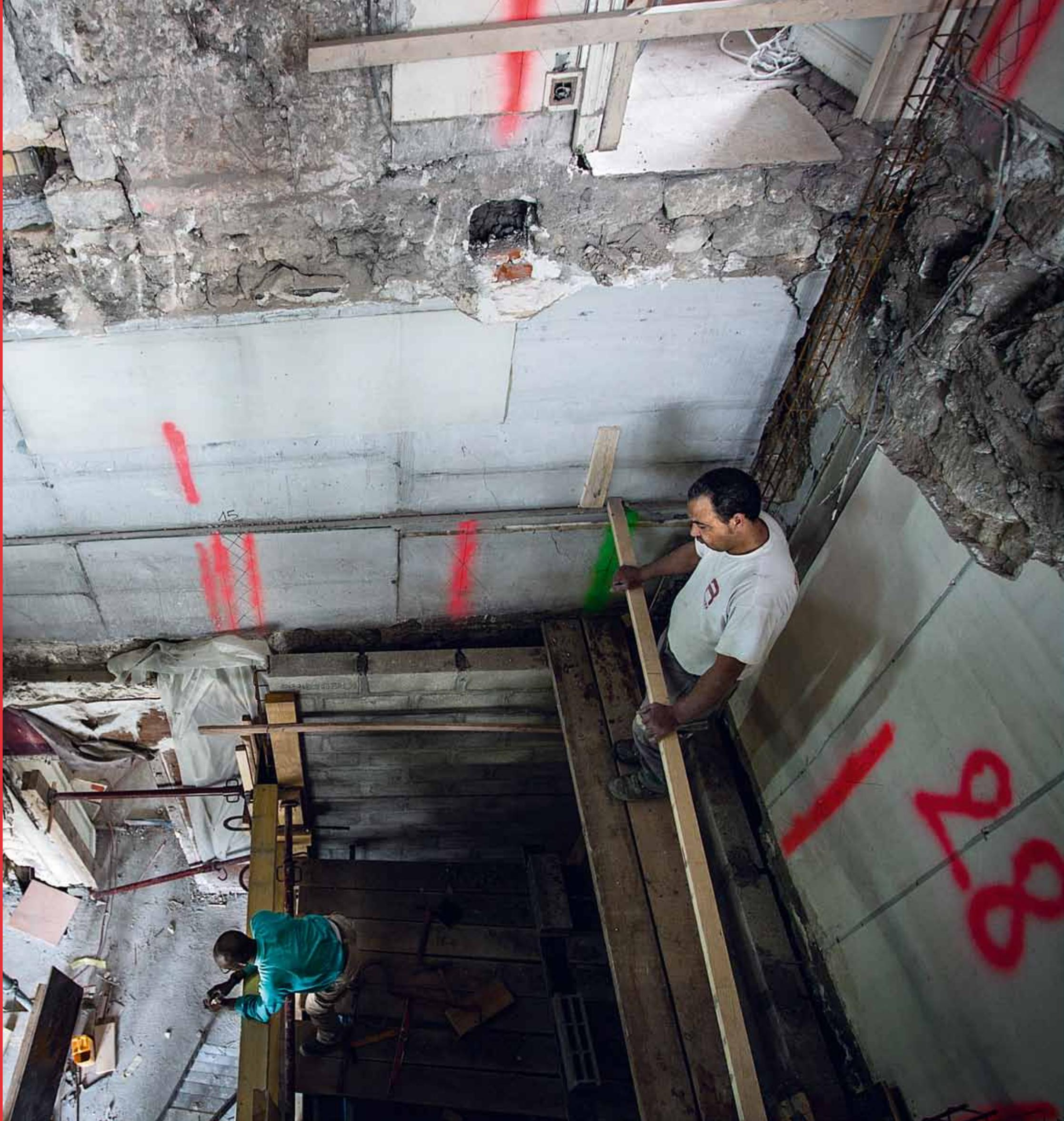
III. TRAVAUX DE CONSOLIDATION DES POUTRES À L'ENTRESOL
